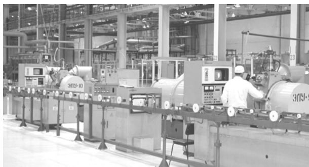
Рис. 21. Автоматическая линия электронно-лучевой сварки ТВЭЛов атомных станций, оснащенная пушками с плазменным эмиттером
